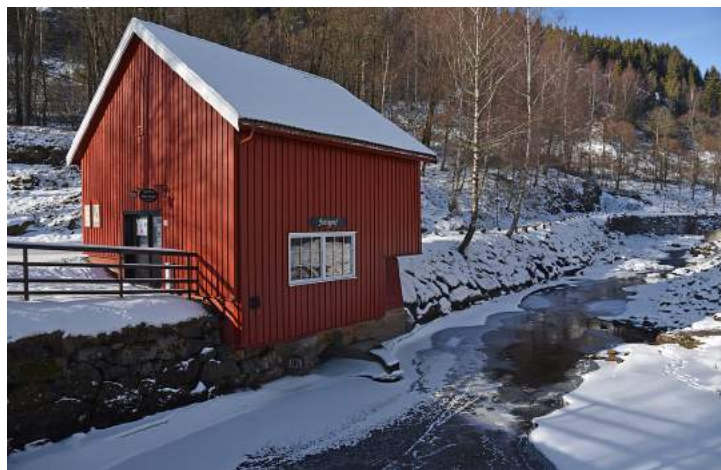
Verksfossen elektrisitetsbygningen - turbinbygningen.
