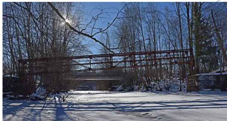
Bærums Verks Sag og Høvleri – fagverksbrua fra sag til høvleri.
