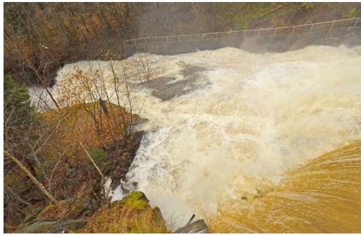
Spikerbrukfallet i flom.
