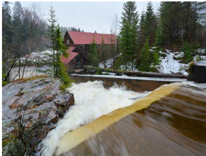
Guriby Sag med rørdledning.
