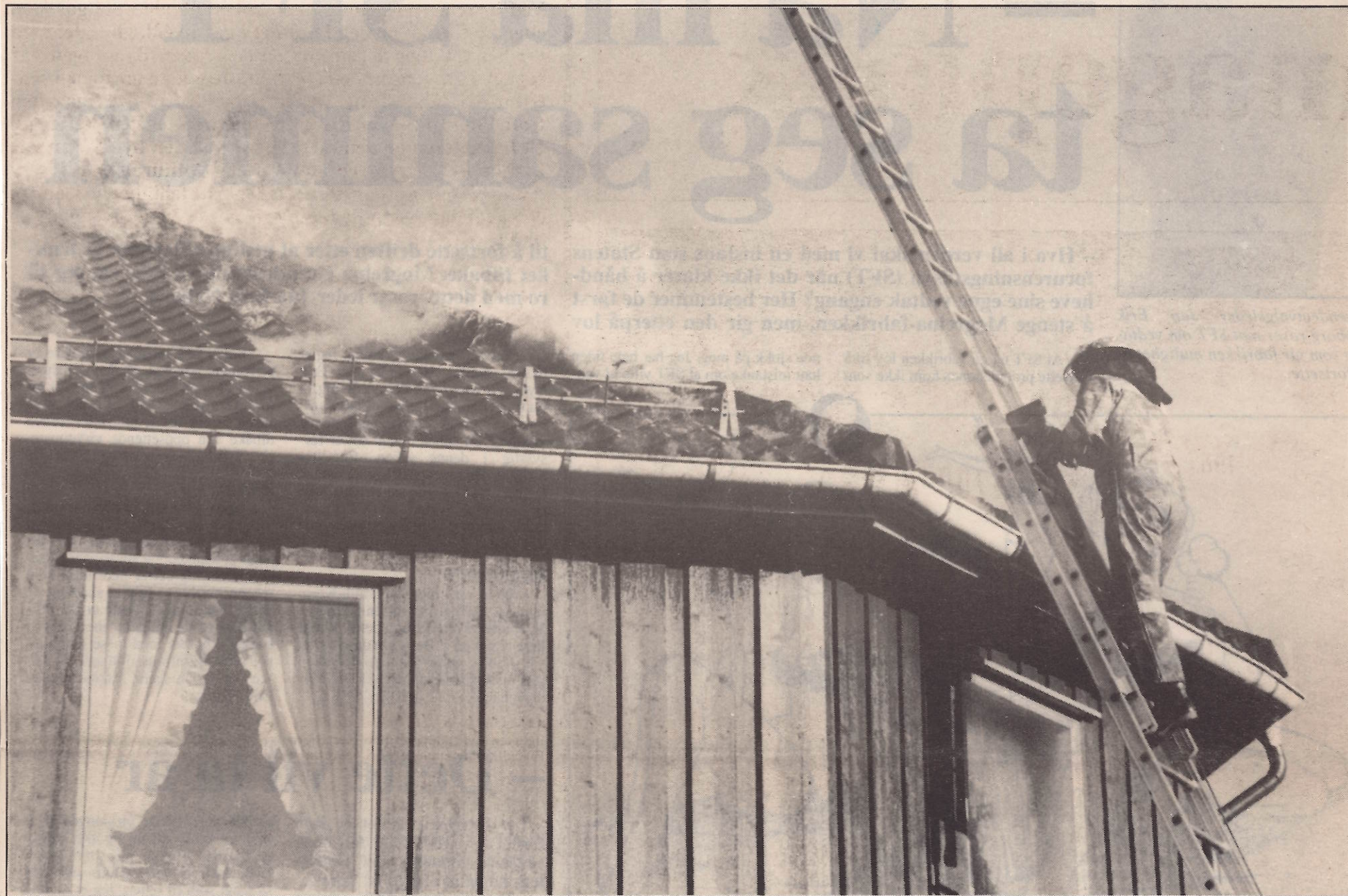
En nærmest håpløs kamp mot flammene gjennom ståltaket.
