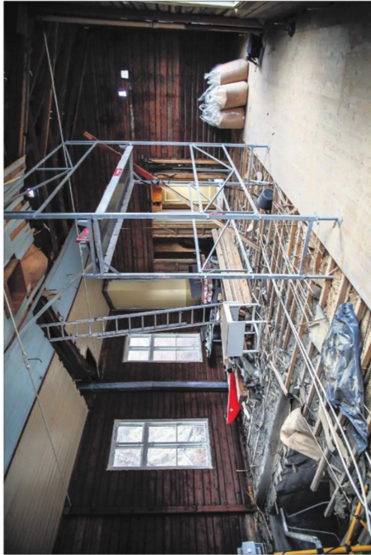
GÅR FOR GJENBRUK: Så mye som mulig skal gjenbrukes når bygget innredes på nytt, men først skal sløtt tømmer i laftekassa byttes ut. Storsalen blir stue med mesanin.
